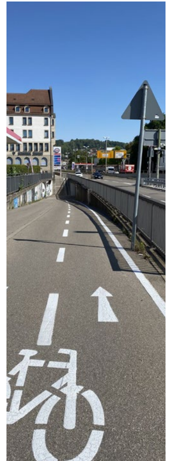
Radweg entlang der B10
